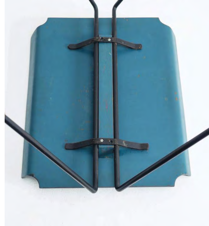
Das formgebogene Tischblatt aus Ahornsperrholz ist mit einem konischen Massivholzträger darunter verleimt. Dieser liegt auf einem Rundrohr-Untergestell auf. Ein am Untergestell angeschweisster Bügel hält mit zwei bis vier Schrauben den Massivholzträger fest und gibt so die notwendige seitliche Festigkeit an das lose aufgelegte Tischblatt weiter.
