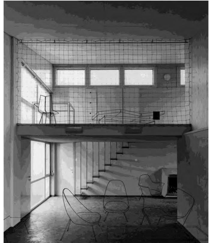
Die Galerie des zweigeschossigen Wohnraums ist mit einem luftigen Netz anstelle eines üblichen Geländers versehen.
