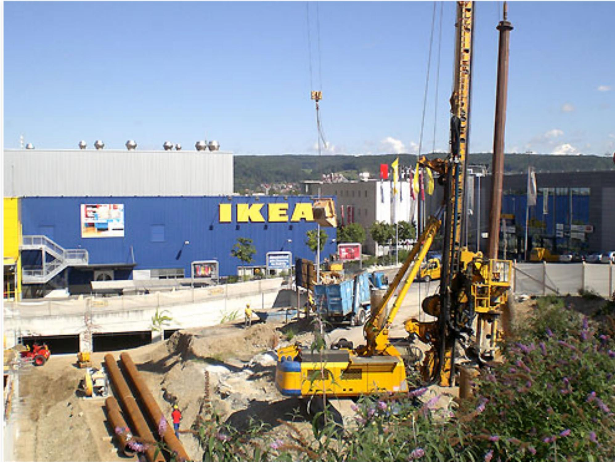
Vorbohrung mit Bauer BG40 Bild: Conrad
